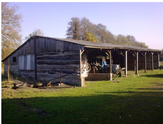
Schuur 2, 254 m2. Conform eerdere afspraken (brief d.d. 26 januari 2012, kenmerk 1200016229 SO) reeds afgebroken. Oppervlakte telt wel mee in berekening.
