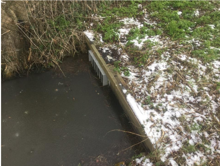
Figuur 6 Instroom van de sifon van het afwijkende peil 25A
