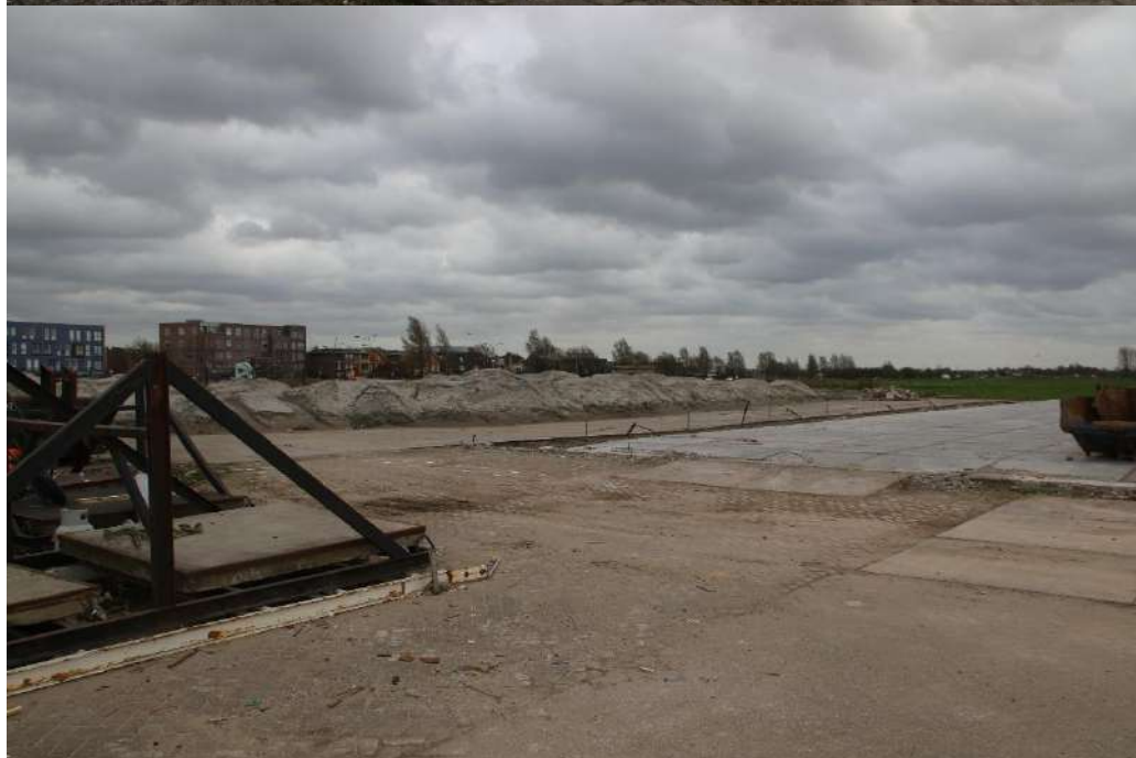
Locatie met huidige verharding en werkzaamheden
