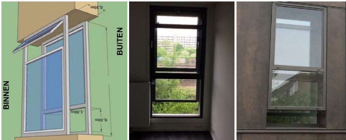
Figuur 6.2: Harbour Fenster – principe (links), binnenaanzicht (midden) en buitenaanzicht (rechts)
