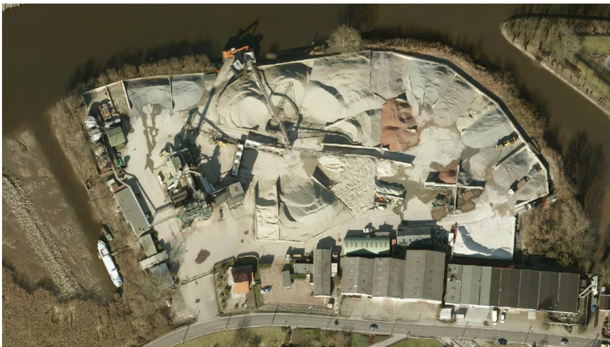
Figuur 3 De Koudasfalt-fabriek in bedrijf (luchtfoto 2010)
