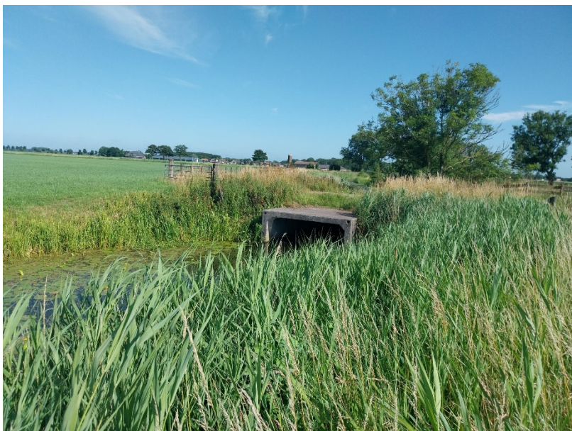
Aanwezige duiker, 100 meter noordelijk van de te vervangen brug (vooraanzicht)
