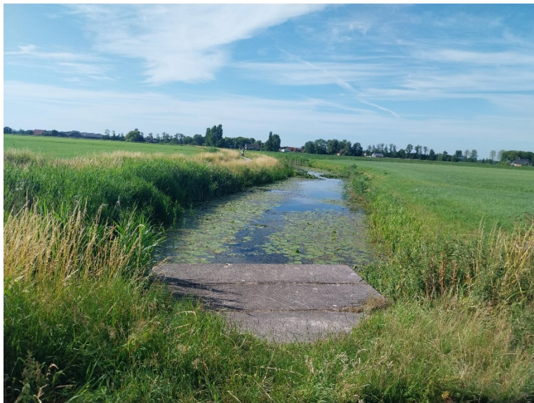
Aanwezige duiker, 100 meter noordelijk van de te vervangen brug (boven aanzicht)
