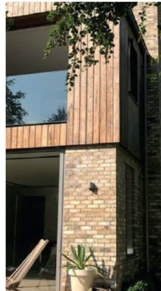
Zorgvuldige detaillering in metselwerk en aansluiting regenwaterafvoer.
