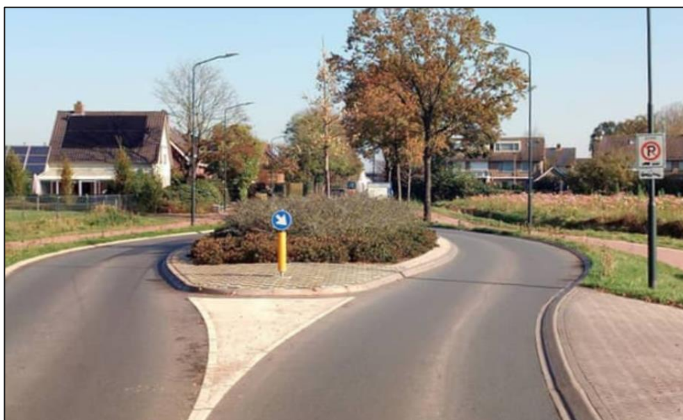
Figuur 5.2: Voorbeeld van een chicane in de weg waardoor verkeer zonder drempels wordt afgeremd
