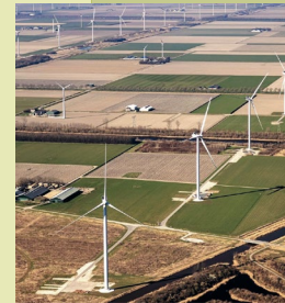
Aanleg grid van windmolens
