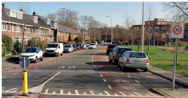
Afbeelding 5 | Voorbeeld poortconstructie op Prinses Irenelaan.
