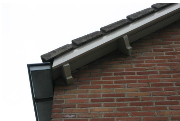
Figuur 4.2.2. Op de gladde lat onder de gevelpannen hebben vogels of vleermuizen geen houvast.
