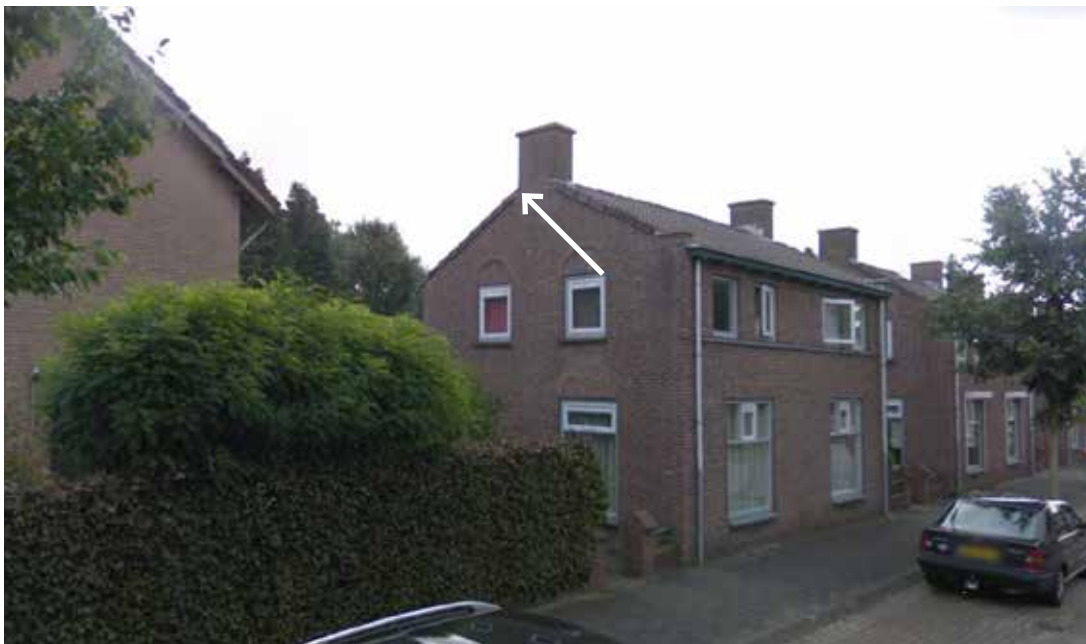
Figuur 4.3 : Verblijfplaats Van Rijckevorstelstraat 59. De verblijfplaats is toegankelijk via een opstaande loodslab.
