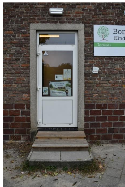
Vernieuwde deur linkerzijgevel.
