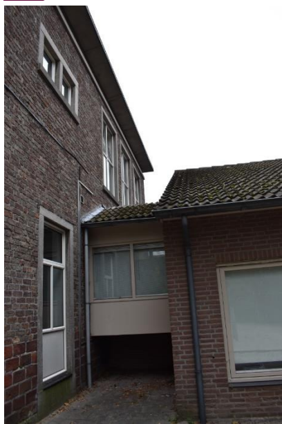
Aanbouw aan de rechterzijde.
