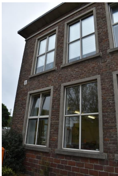
Vernieuwde vensters linkerzijgevel.
