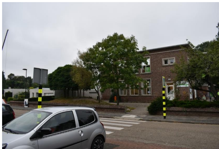
Zicht op de school vanaf de Lijntjesstraat.
