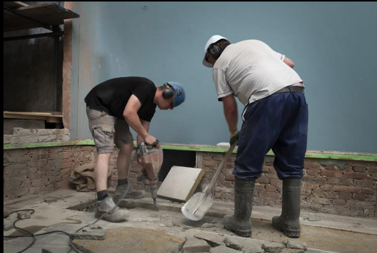
Sloopwerkzaamheden voor Asbestsanering
