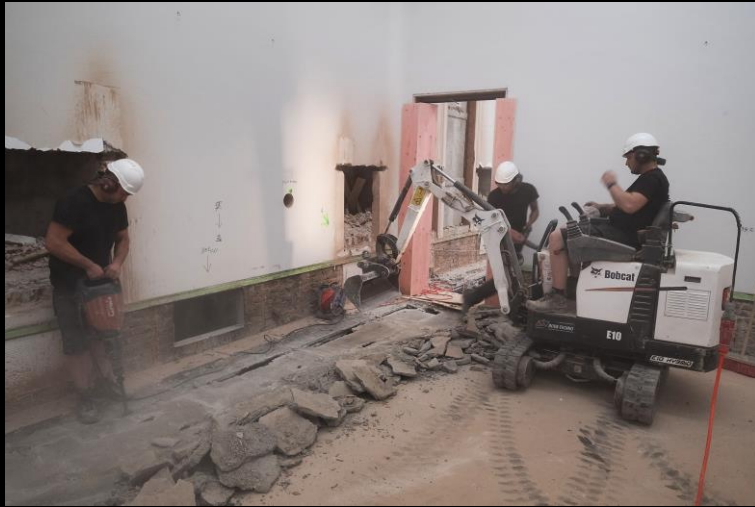
Sloopwerkzaamheden voor Asbestsanering
