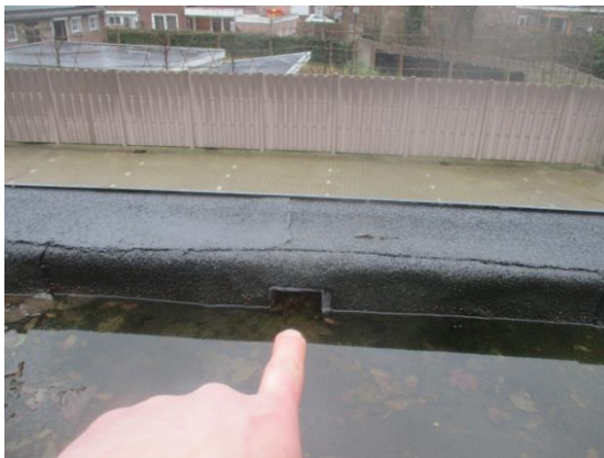
Figuur 3: Punt 1: verstopte hemelwaterafvoer van platdak
