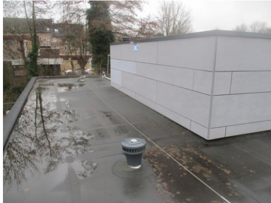
Figuur 2: impressie dak met ventilatoren en gevelafwerking
