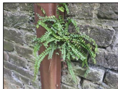
Figuur 5.3. Steenbreekvaren onder brandtrap op noordelijke luchtplaats.
