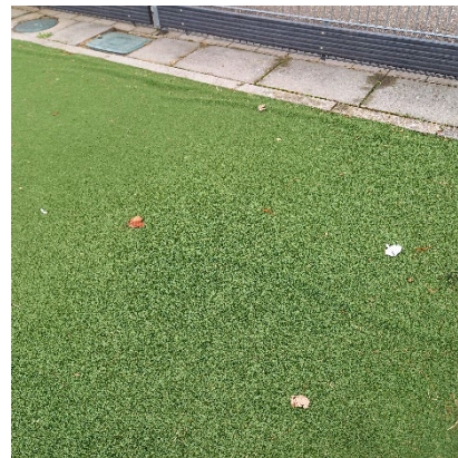
Plooiën in toplaag
