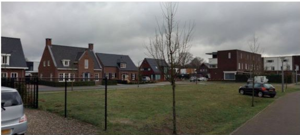
Foto 3 / 9 maart 2021 van nog de in 2020 verkochte percelen aan het noordelijke deel van Hellebaard uit het plan Velmolen Buiten. Gefotografeerd vanaf Hellebaard in noordoostelijke richting.
