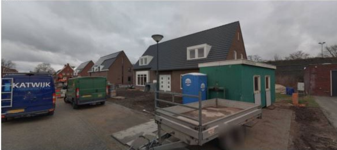
Foto 1 / 9 maart 2021 van de in aanbouw zijnde woningen aan de Gulden. De gronden zijn in 2019 geleverd. Gefotografeerd vanaf Gulden in westelijke richting.
