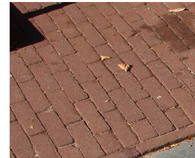
Klinkers, waalformaat rood- bruin op de trottoirs, halfsteensverband
