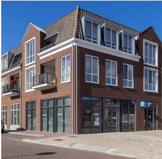
Doorlopende plint zuid- en oostzijde aan straat en plein.
