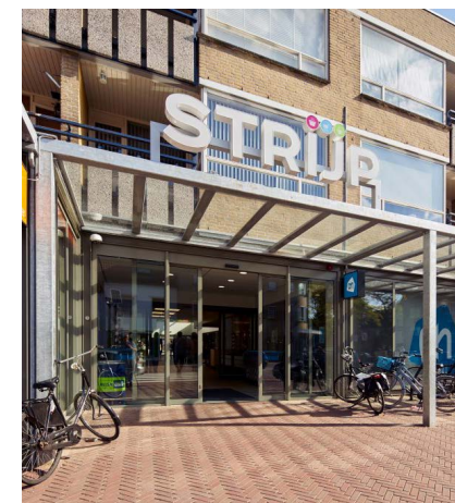
Moderne eenduidige luifel zorgt voor rust en samenhang.
