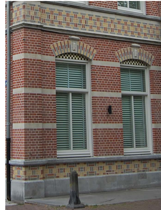
Rode bakstenen en houten kozijnen, speklagen en bijzonder vormgegeven rollagen.
