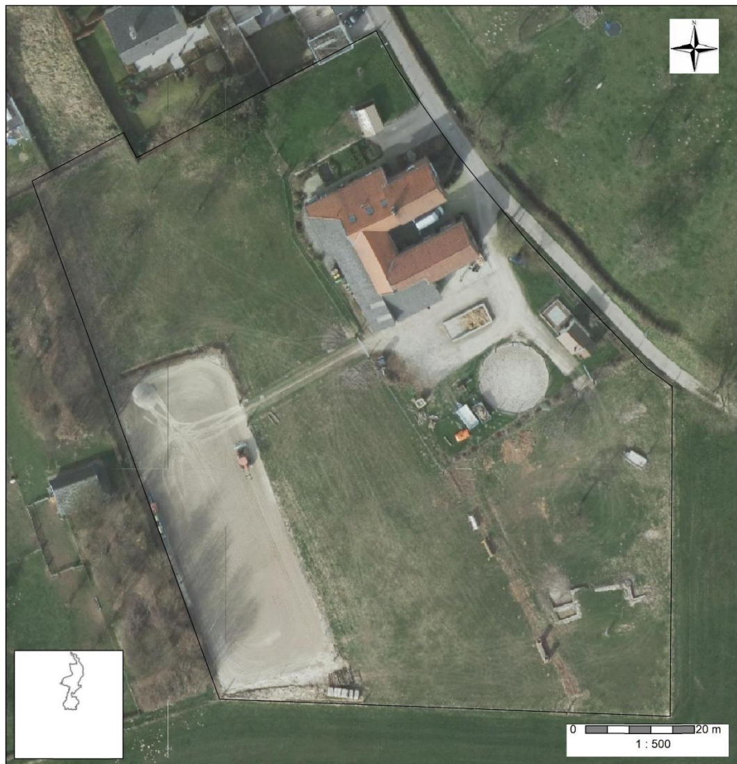
Figuur 3 Overzicht bestaande situatie
