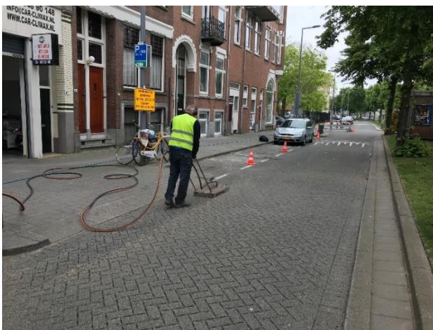
figuur 10: Uitvoering van de reiniging met luchtdruk.
