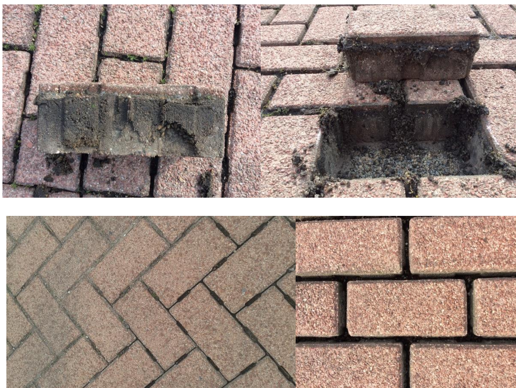
figuur 7: Reiniging WPV's: Voorbeelden van een slecht (links) en een goed resultaat (rechts)
