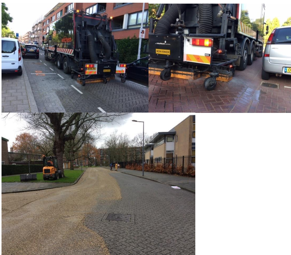
Opnieuw aanbrengen split figuur 9: Reiniging
