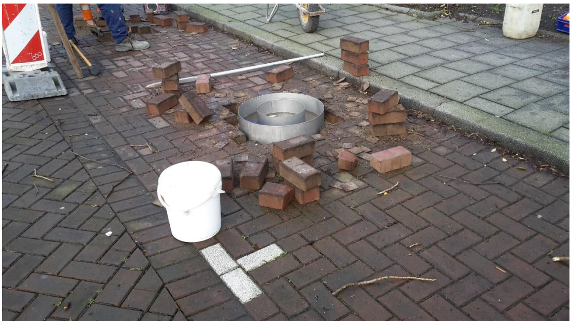
De opengebroken straat met in het wegcunet de DRI geplaatst.
