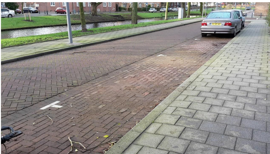
De parkeervakken waar de metingen zijn uitgevoerd. Na het meten is de straat weer hersteld.
