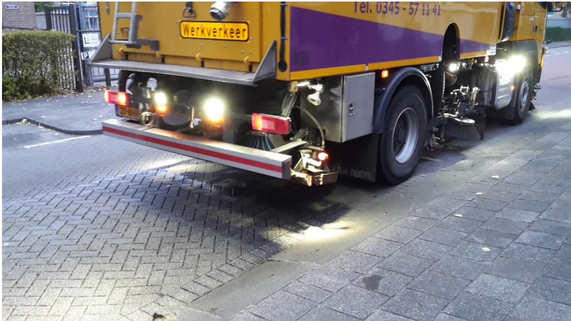
Foto 3: Het reinigen van het wegvak met een ZOAB cleaner
