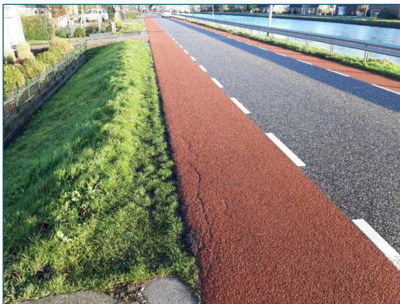
Foto 5. Scheurvorming en randschade Westkanaalweg
