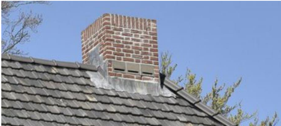
Voorbeeld van een schoorsteen met ingebouwde vleermuiskasten.
