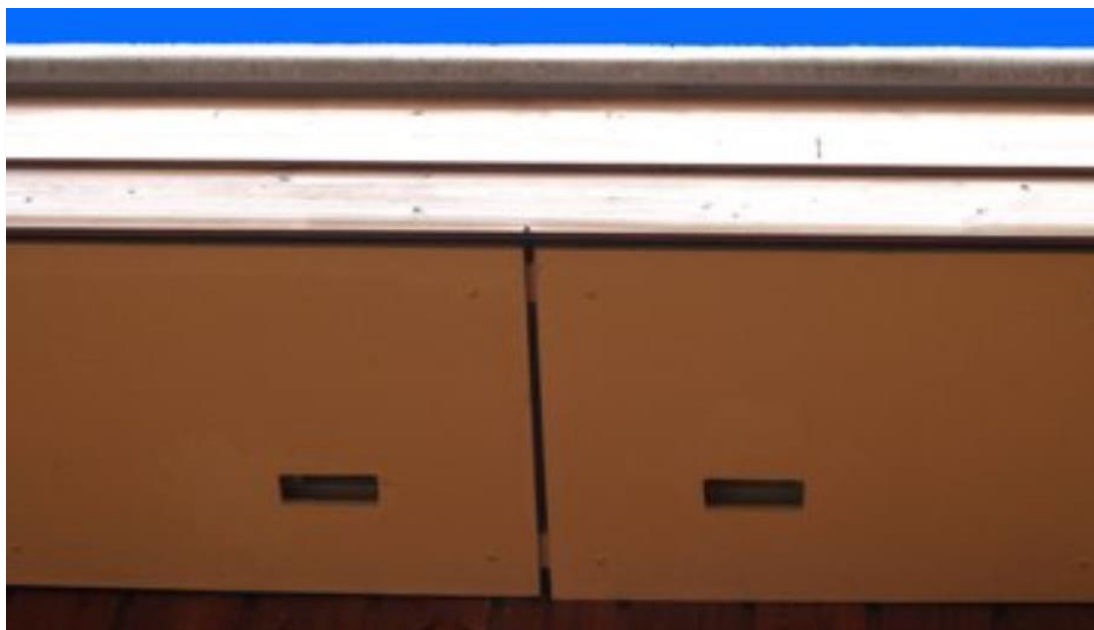
Loze ruimte onder dakgoot met invliegopening voor gierzwaluw.
