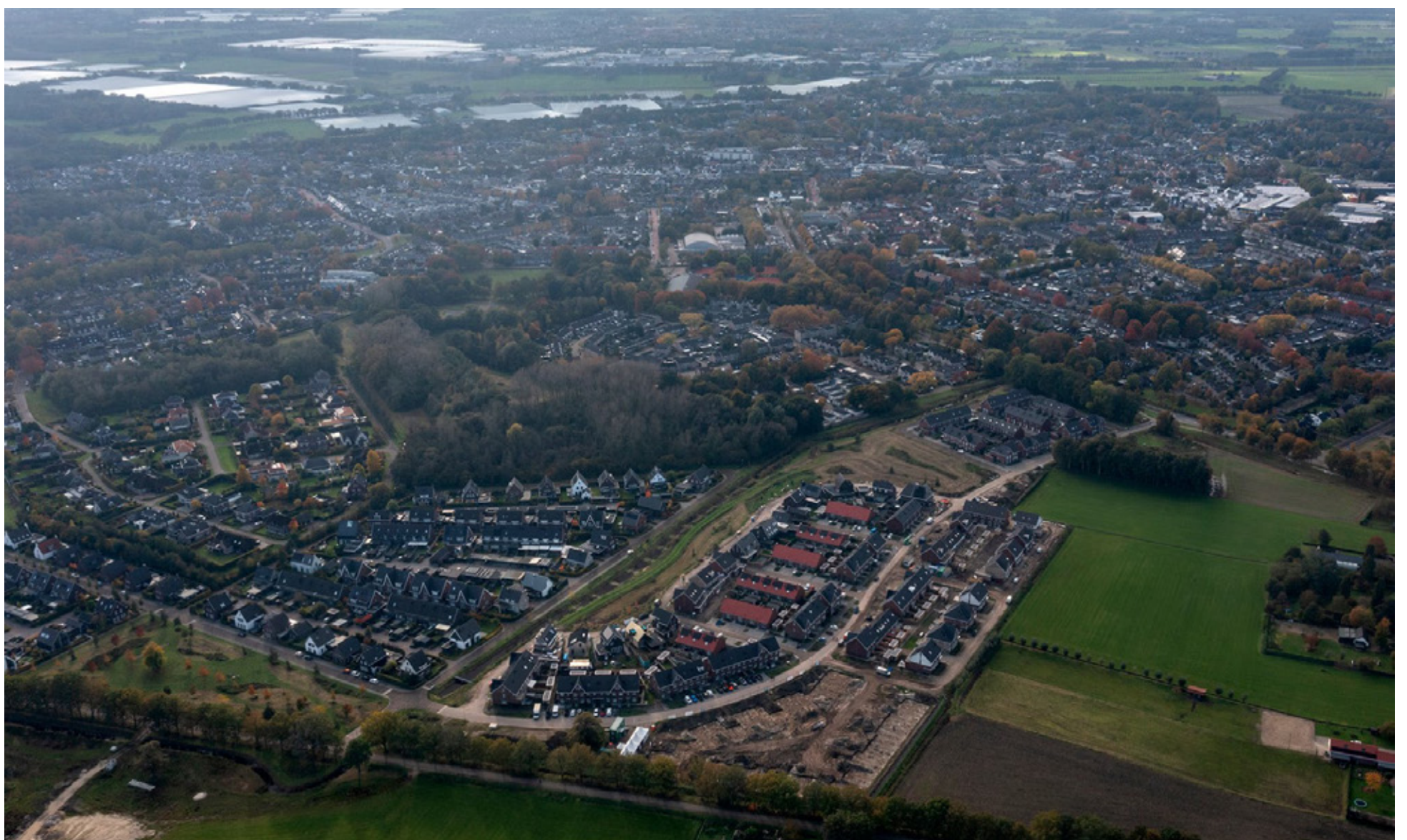
Luchtfoto met Loverbosch II in aanbouw
