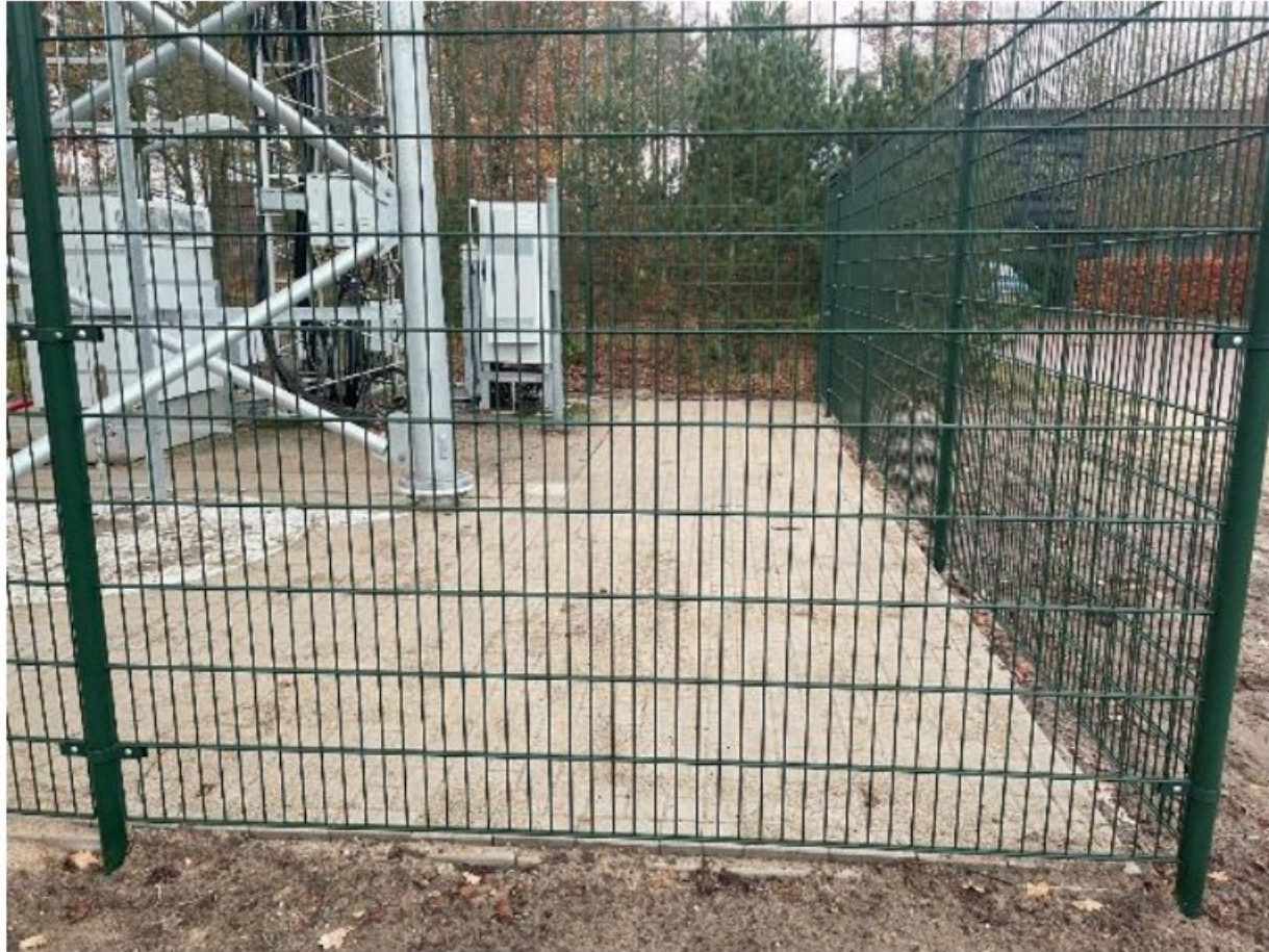
Ruime marge genomen voor hekwerk tov zendmast
