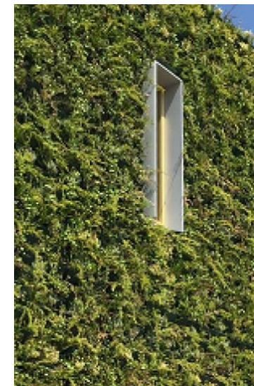
Vergroening van de dichte gevel van de supermarkt zorgt direct voor een prettig beeld langs de Dorpsstraat en werkt klimaatadaptief (koeling)
