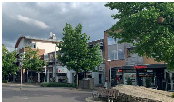
Winkelwand aan Den Hof
