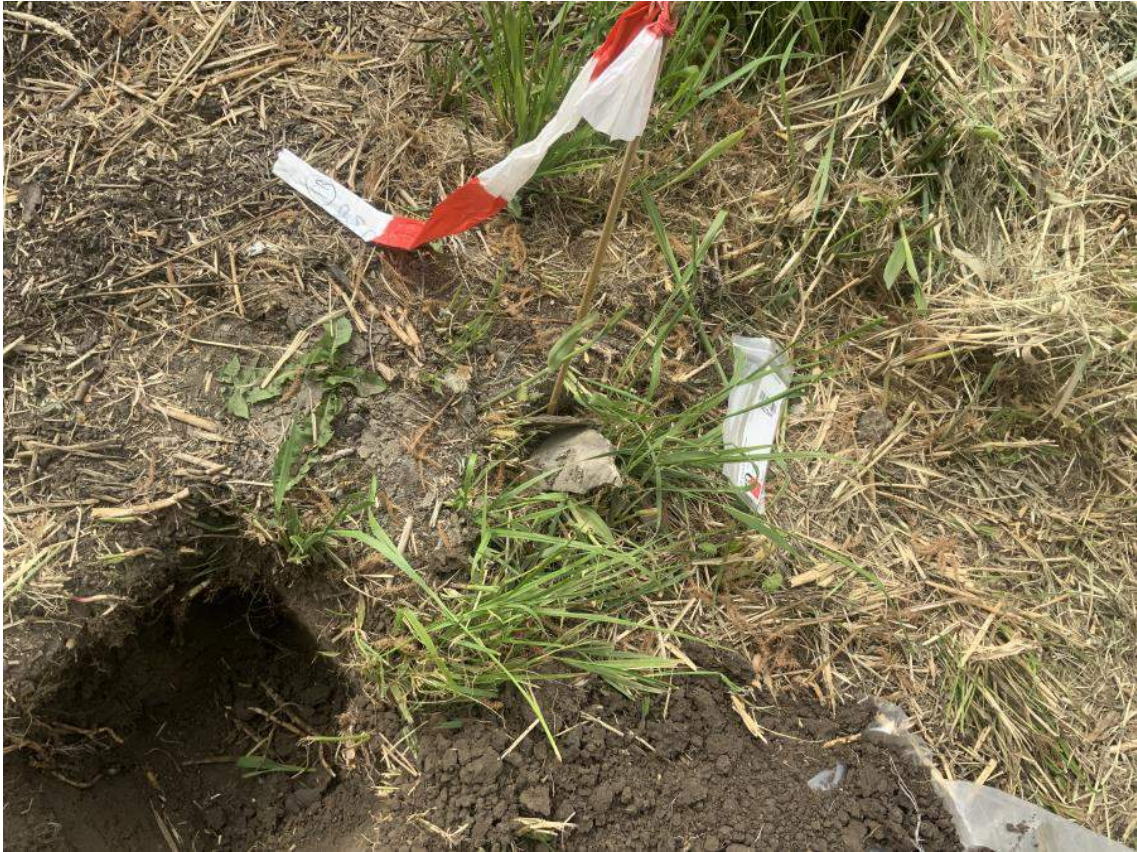
Asbestverdacht materiaal maaiveld -03
