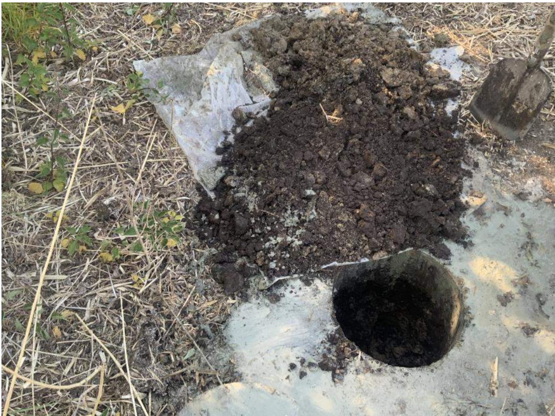
Deellocatie M. (Betonnen middenpaden) Inspectiegat 903
