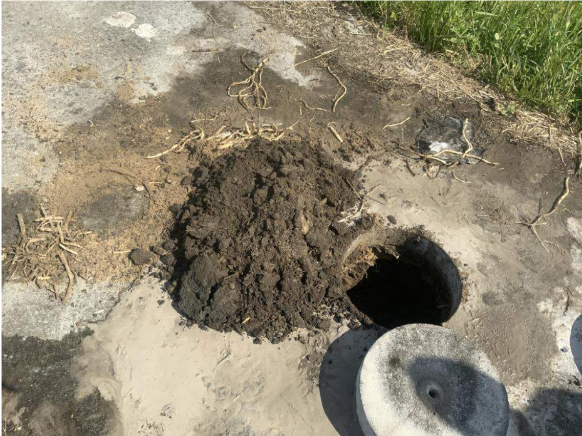
Deellocatie M. (Betonnen middenpaden) Inspectiegat 906
