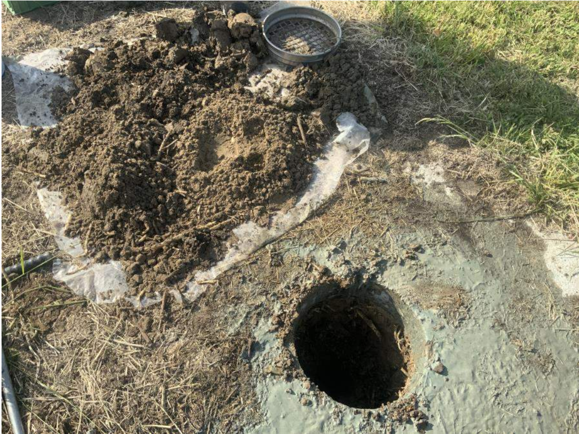
Deellocatie M. (Betonnen middenpaden) Inspectiegat 902
