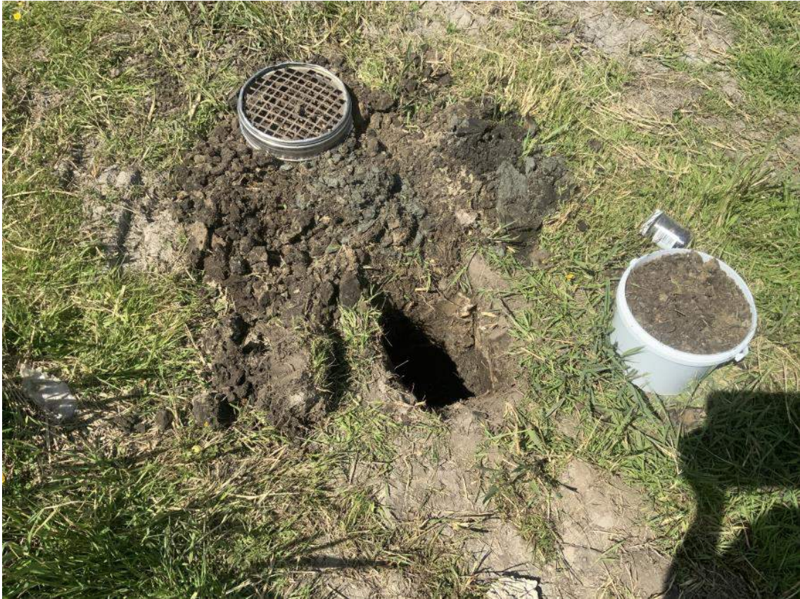
Deellocatie L. (Dammetjes) Inspectiegat 802
