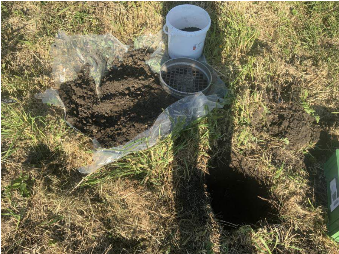
Deellocatie K. (Stuurboordstraat naast 12) Inspectiegat 701
