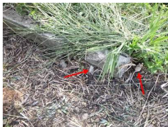
Foto 10 | Foto voor bron Restanten golfplaat
