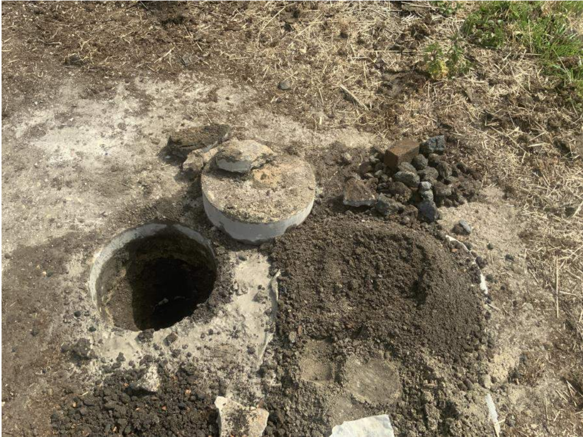
Deellocatie M. (Betonnen middenpaden) Inspectiegat 908
