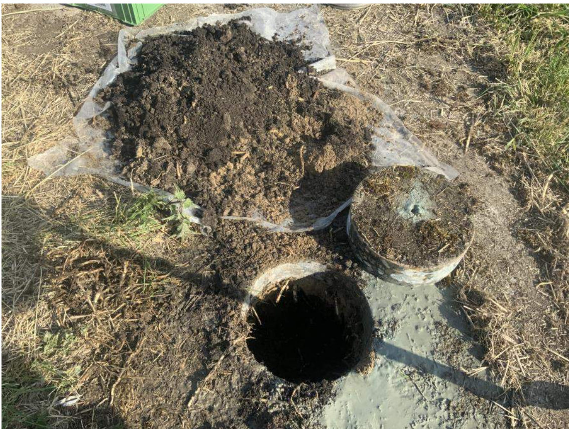
Deellocatie M. (Betonnen middenpaden) Inspectiegat 901
