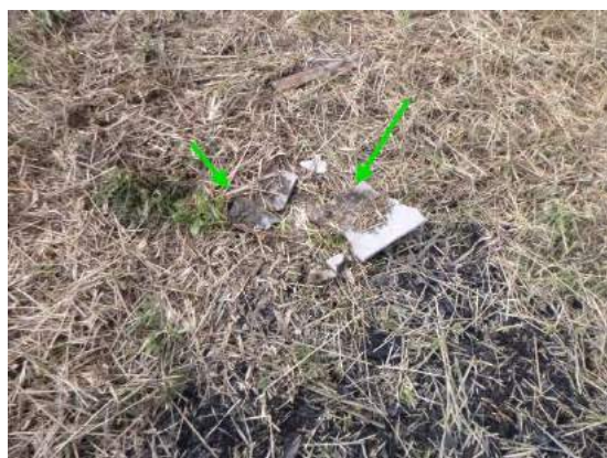
Foto 1 | Foto voor bron Restanten plaat
