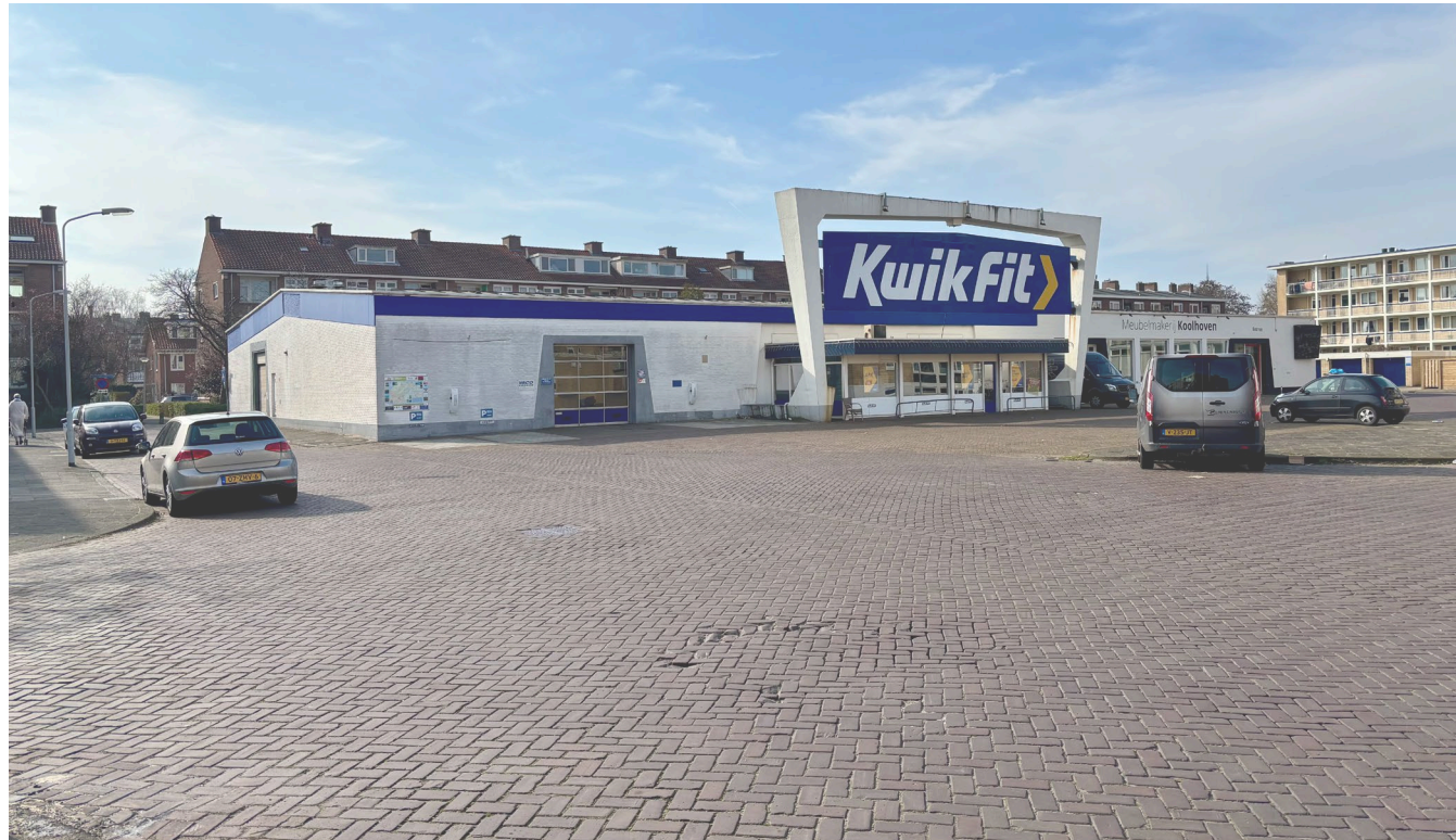
In de voorgevel zijn zowel het metselwerk als de portalen beschilderd, wat afbreuk doet aan het oorspronkelijke contrast
