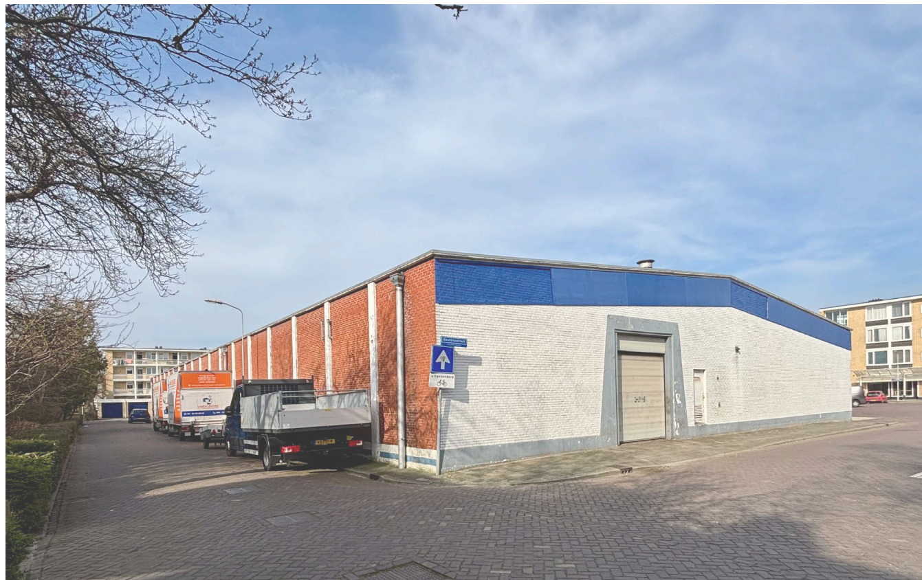
Gevel gedeeltelijk bedekt met boeiboord
