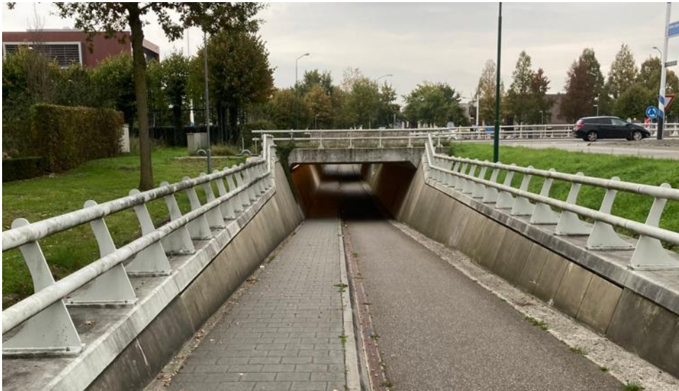
Figuur 5 Fietspad Velmolenweg-west.
