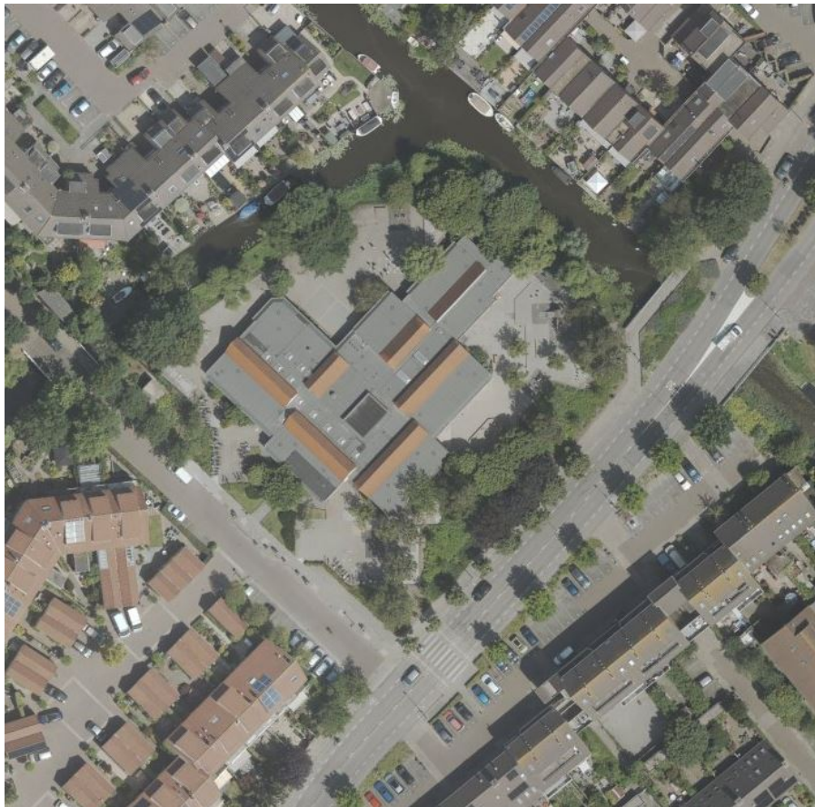
Afbeelding luchtfoto bestaande situatie
