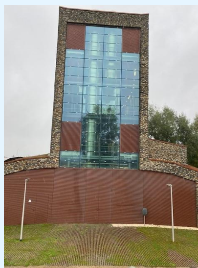
figuur 4: zuidgevel HWC
