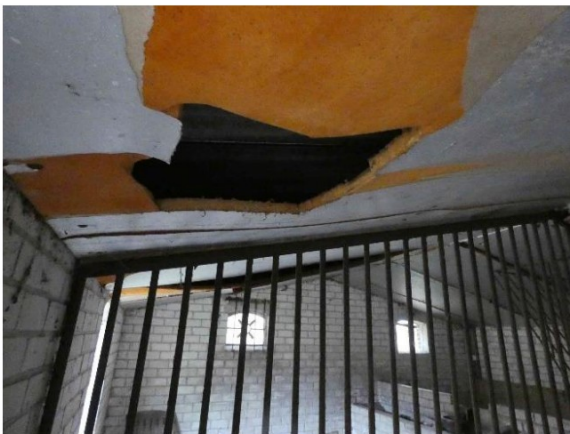
Staldeel met dakplaten
