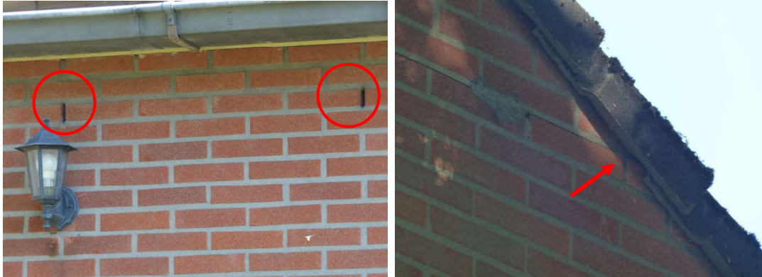
Foto 6 Open stootvoegen (links) en ruimte onder kantpannen (rechts) bieden invlieggelegenheid voor vleermuizen.
