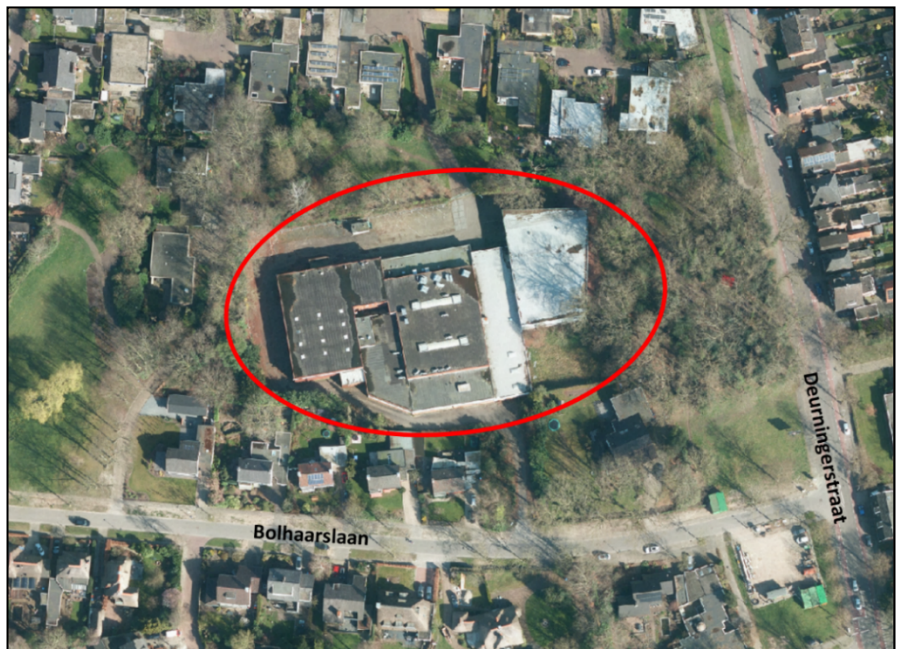
Luchtfoto met de bestaande wasserij
