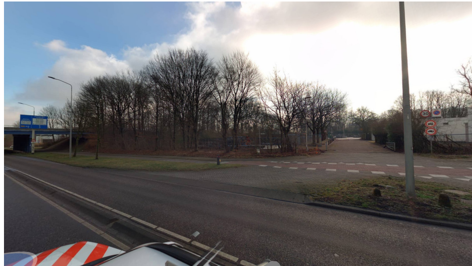
Situatie winter De ligging van het station aan de Imstenraderweg / Euregioweg de zichtrelatie vanaf de openbare weg richting het bestaande gebouw en het toekomstige inpassingsgebied.
