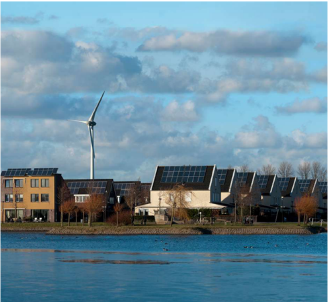
Energie-opwekking in een woonwijk
