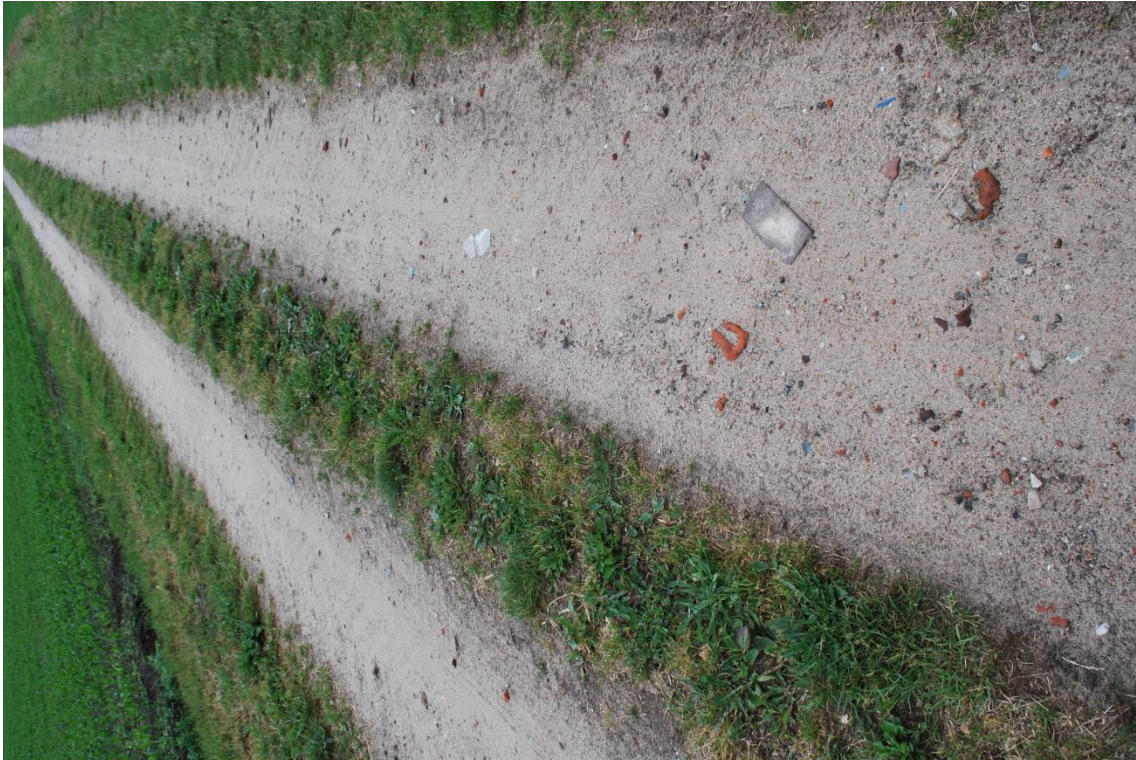
Afbeelding 5: halfverharding Kromsteeg met ongesorteerd puin
