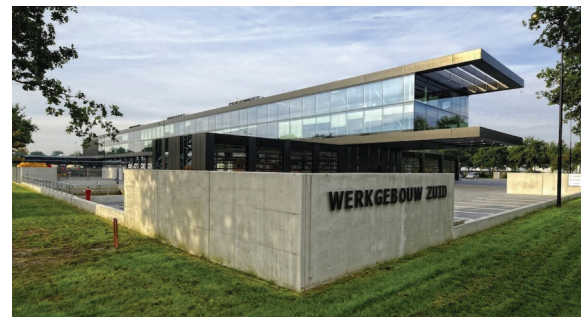
Gebouw als paviljoen in het groen
