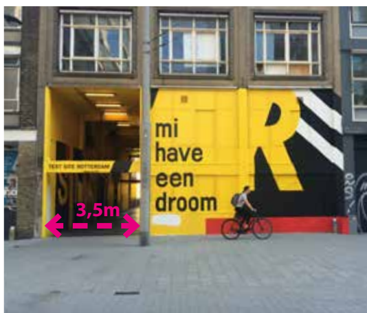
huidige smalle doorgang met blinde gevels
