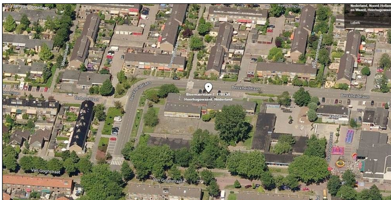
Figuur 13. Luchtfoto oude situatie met basisschool (bron: Bing.nl) .
