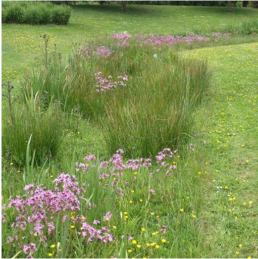
Afkoppelen en infiltreren hemelwater (wadi)
