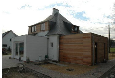
Afbeelding 9 aanbouw voldoet niet
