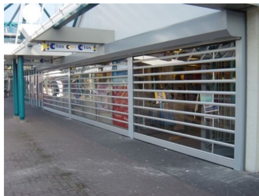
Afbeelding 48 rolluik voldoet / bak en geleiders voldoen niet
