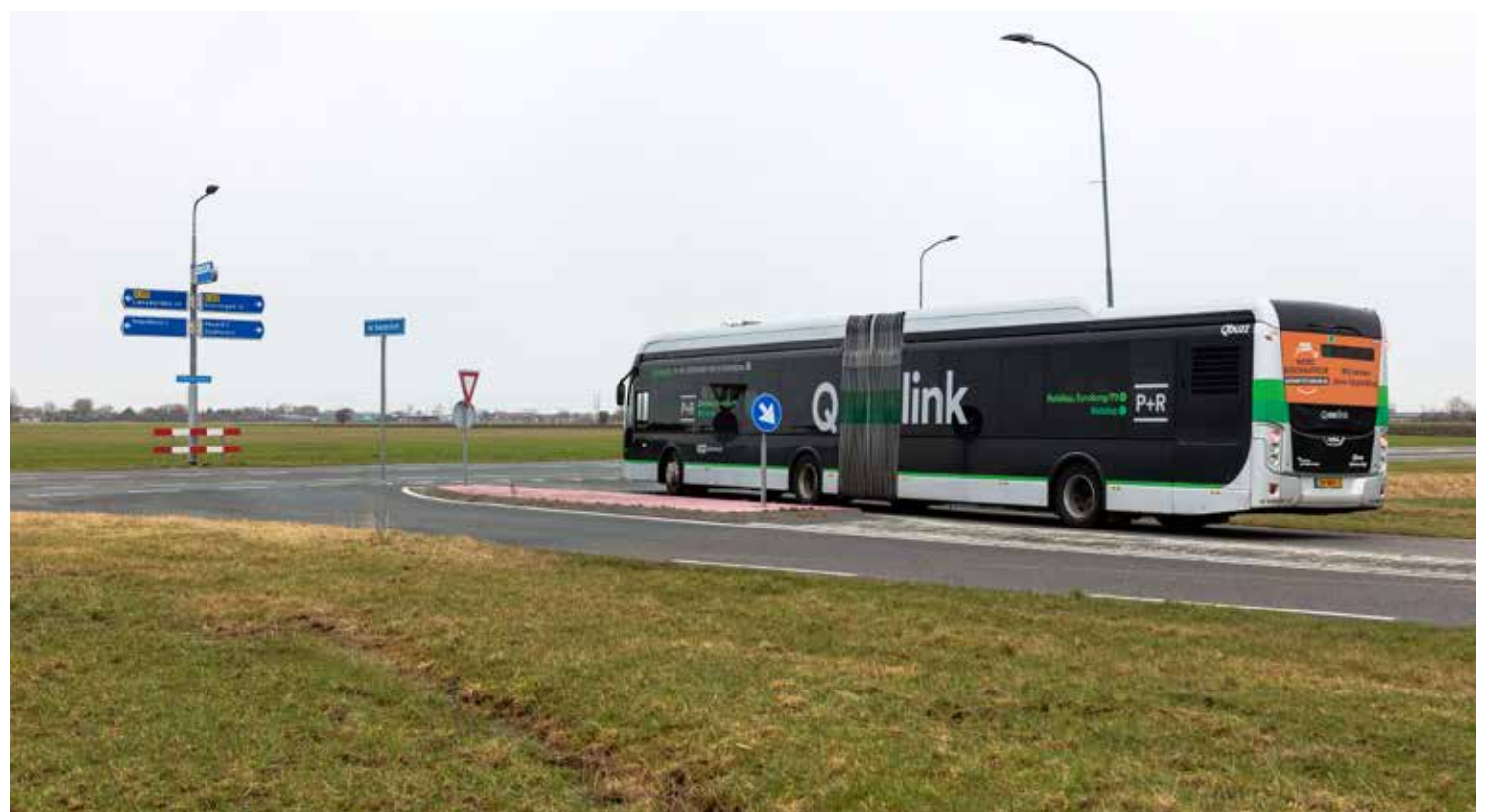
Op deze kruising op de N355-Noorderlicht bij Zuidhorn komen tijdelijke verkeerslichten. Zo kunnen bussen beter doorrijden richting Groningen als het druk is op de weg. Foto: Jan Buwalda.
