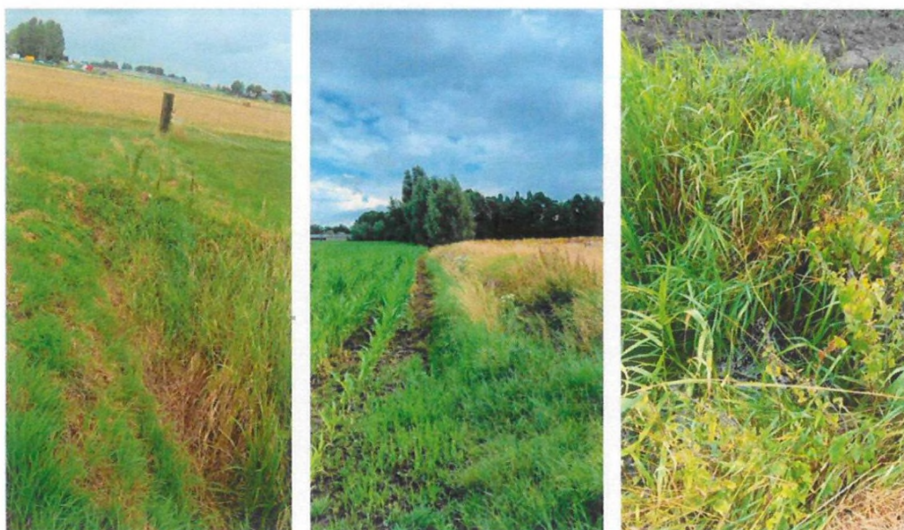
Figuur 9: Het huidige sloten- en greppelsysteem lijkt op dit moment niet integraal verbonden. Veel greppels eindigen zonder duiker of aansluiting op een andere greppel.
