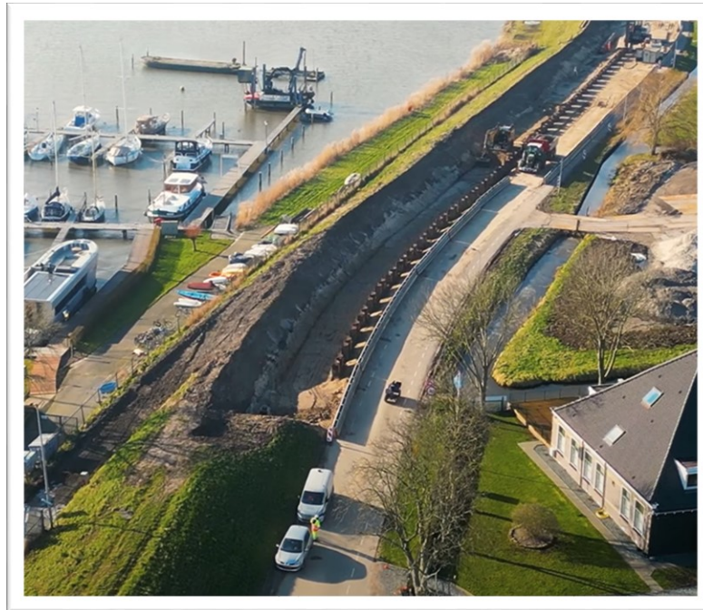
Plaatsen damwanden Katwoude nabij de haven
