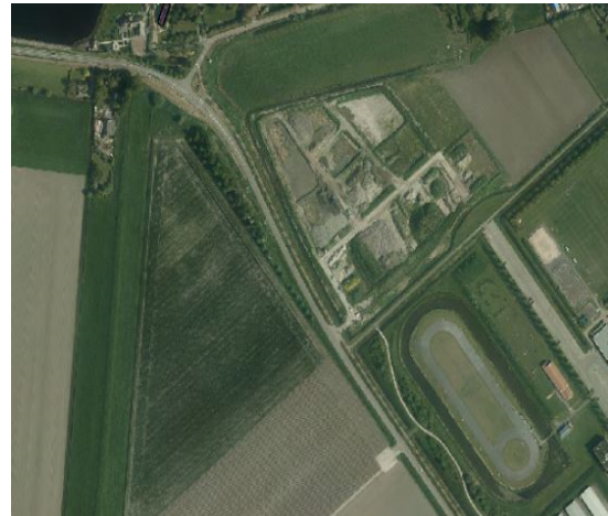
Afbeelding baggerdepot Ambachtsheerweg
