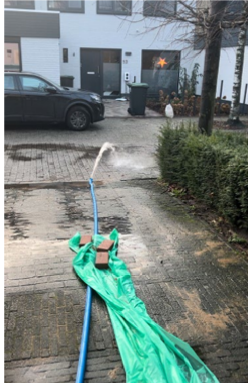
Afbeelding 2: Afvoeren met één pompomp van overtollig bodemwater uit de kruipruimte naar het riool.
