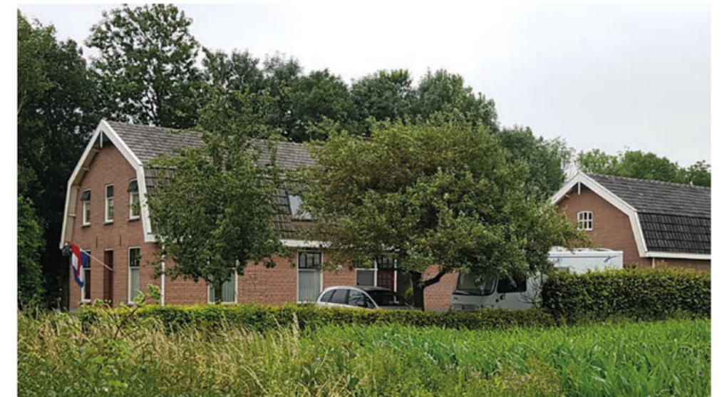
De woningen hebben een langgerekt volume
