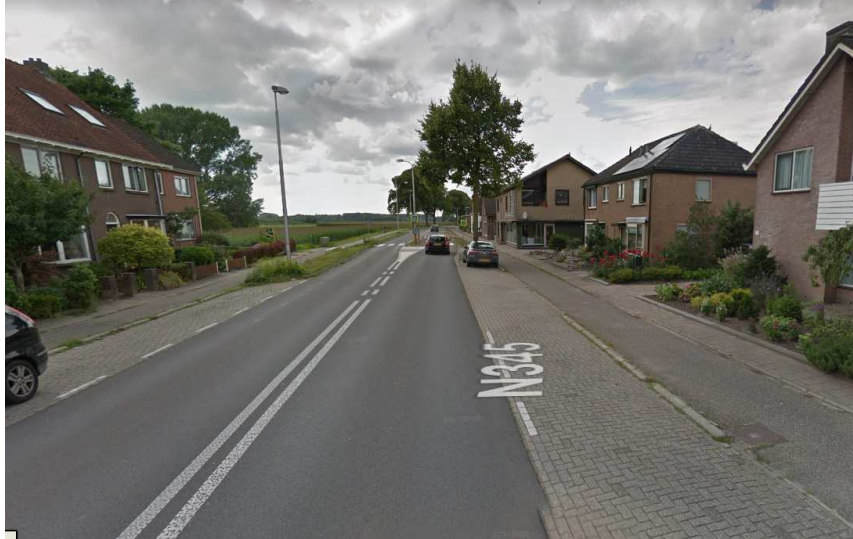
Figuur 2.1: Bestaande vormgeving N345
