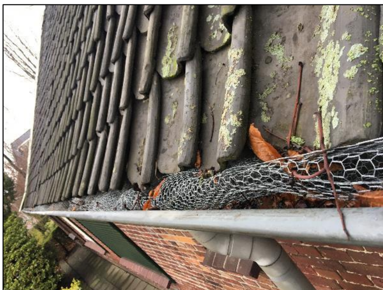
Gespannen gaas voor de onderste rij dakpannen.
