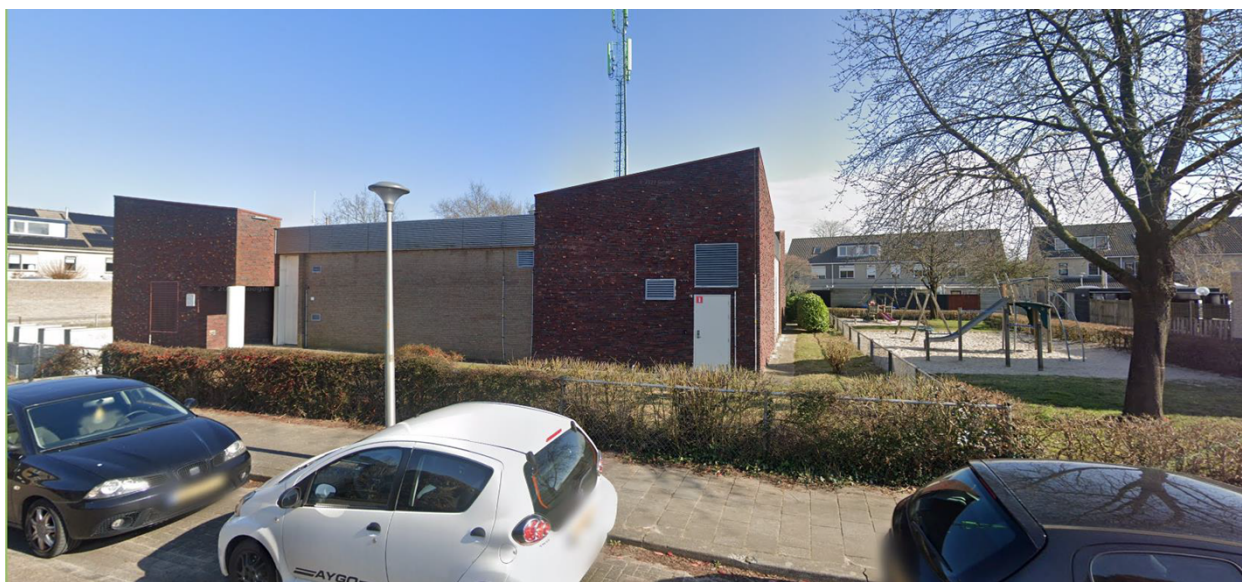
Afbeelding 2.2 Zicht op het gebouw en de begrenzing met het speeltuintje. Op de achtergrond de woningen aan de Vrouwenlaan
