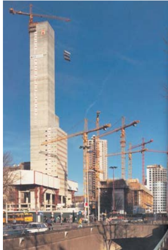
Rotterdam in aanbouw
